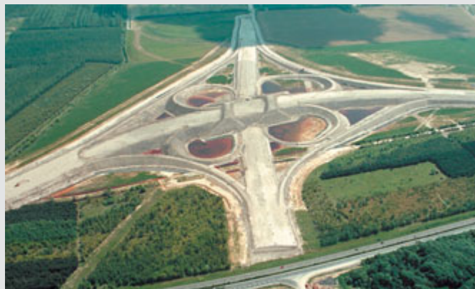
Bild 10: Groberdbau Anschlussstelle Leipzig Süd während der Liegezeit
