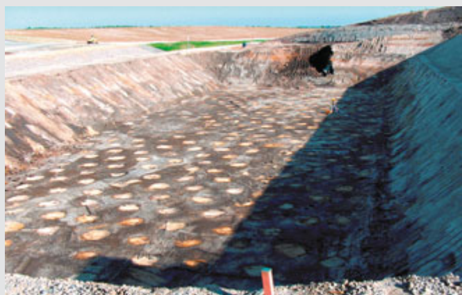
Bild 9: Gründungsfläche für ein Brückenwiderlager nach RSV
