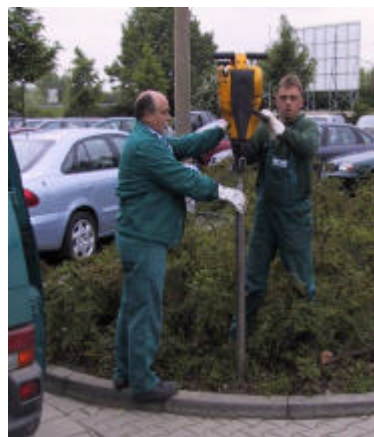
Bohrsondierung zur Baugrunderkundung
