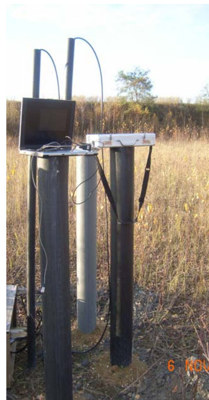
Gebertest nach Einbau
