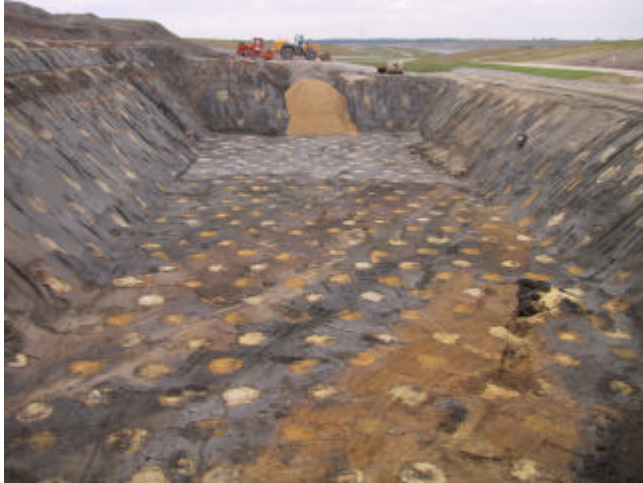
Abb. 7: Kiessäulen für ein Fundament
